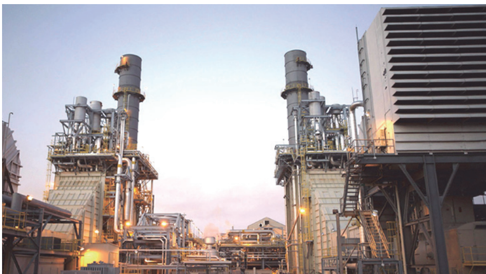
Termoelectrica de Mexicali
